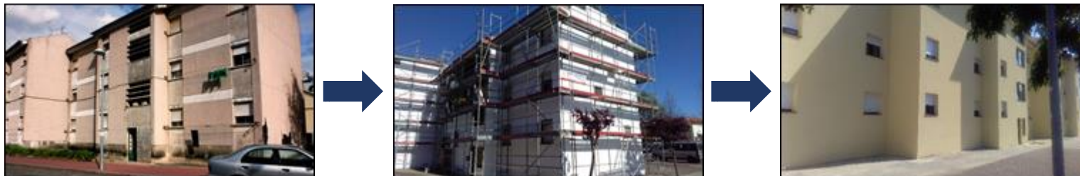
Arcozelo (Barcelos): obra concluída
